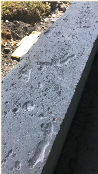
Lofbólugöt sem þarf að kítta í undir þéttiborða
