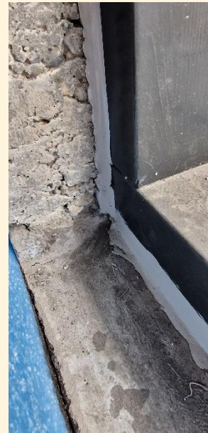
Búið að kítta yfir steypuhreiður
